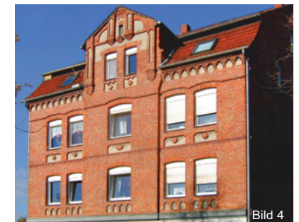
Die Klinker-Fassade wurde mit Isophob-F hydrophobiert.
