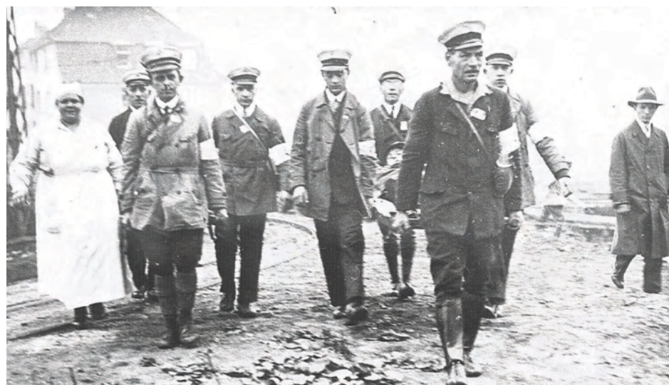
1928: Der ASB übt den Einsatz zur Versorgung bei einem Arbeitsunfall.
