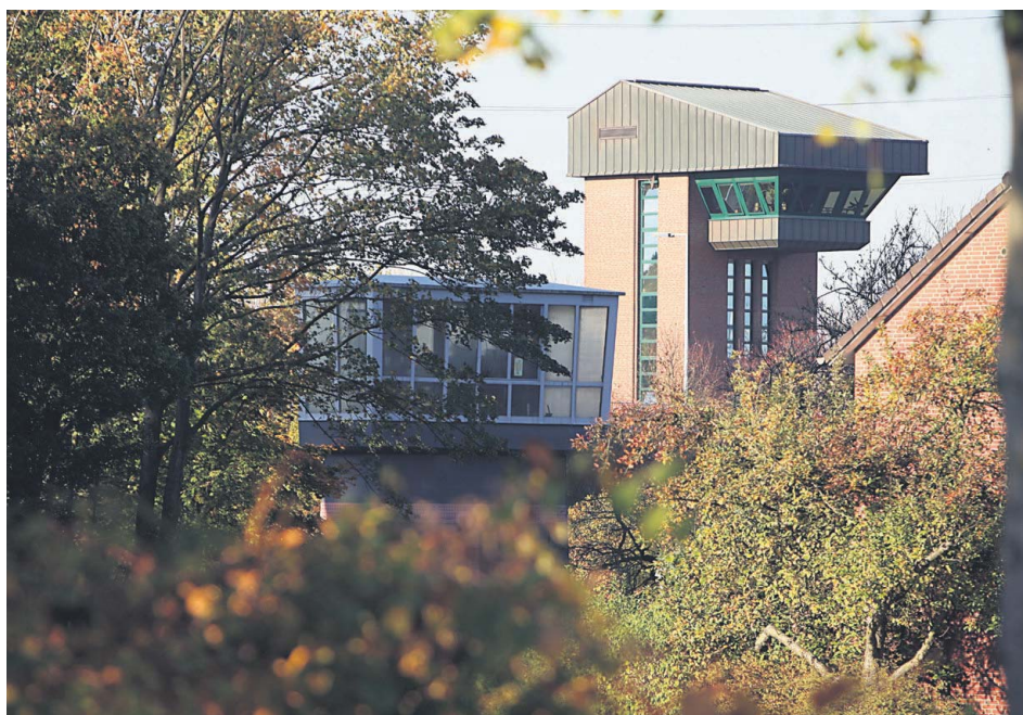
Der Schleusenpark Waltrop gilt als europaweit einmalige Ansammlung von Abstiegsbauwerken. Hier ein Blick auf den Turm der neuesten Schleuse von 1989, davor ein Turm des Neuen Schiffshebewerks von 1968.
