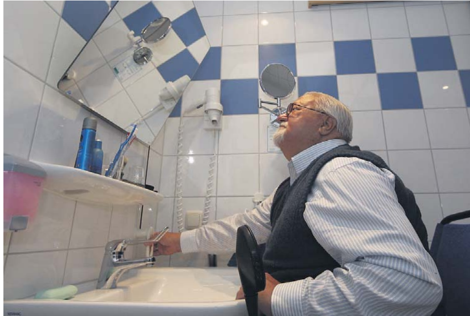
Verstellbare Einbauten wie dieser kippbare Spiegel erleichtern es, das Bad auch im Sitzen noch selbstständig nutzen zu können. FOTO: JENS KÖHLER
